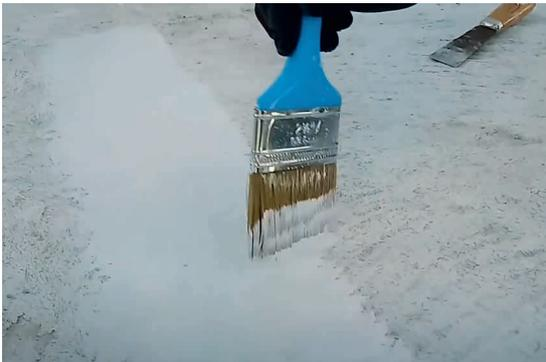
Imprimación para colocación de malla
