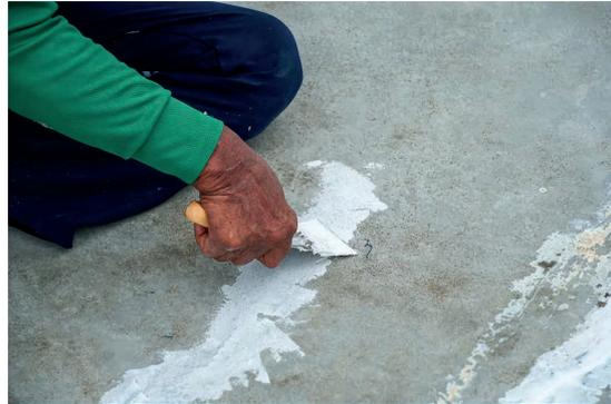
Sellado de fisuras con mortero plástico
